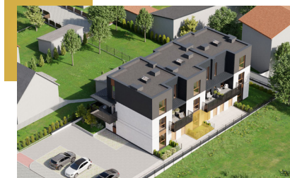
Widok budynku z lotu ptaka
